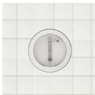
3. Voici à quoi ressemble le baquet fibre une fois le plastique retiré.
