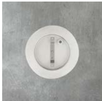
1. Le pot est coulé dans le béton du mur de la piscine.
