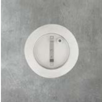
1. Der Topf wird in den Beton der Beckenwand eingegossen.
